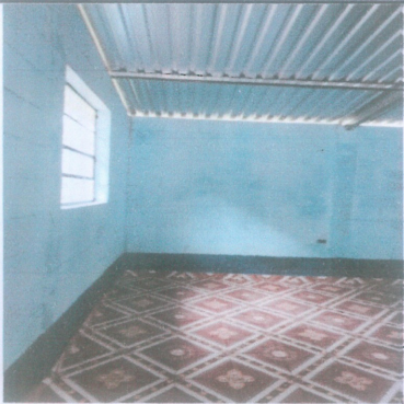
Foto1: Vista interior del módulo .
