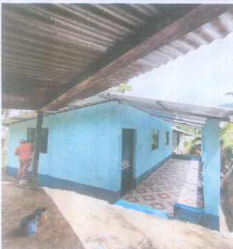
Foto 3: Instalación de ventanas.
