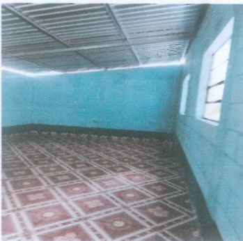
Foto 2: Vista lateral del módulo .
