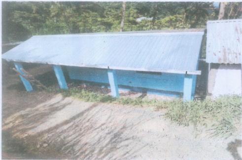
Foto 5: Mejoramiento al módulo finalizado
