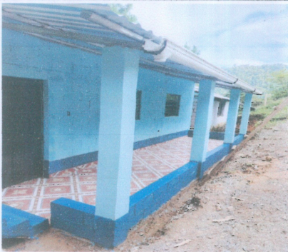
Foto 6: Vista lateral del aula terminada.
